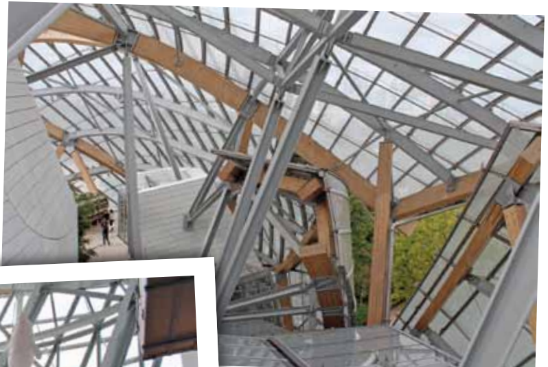
Vista de la parte superior a la base del edificio.
